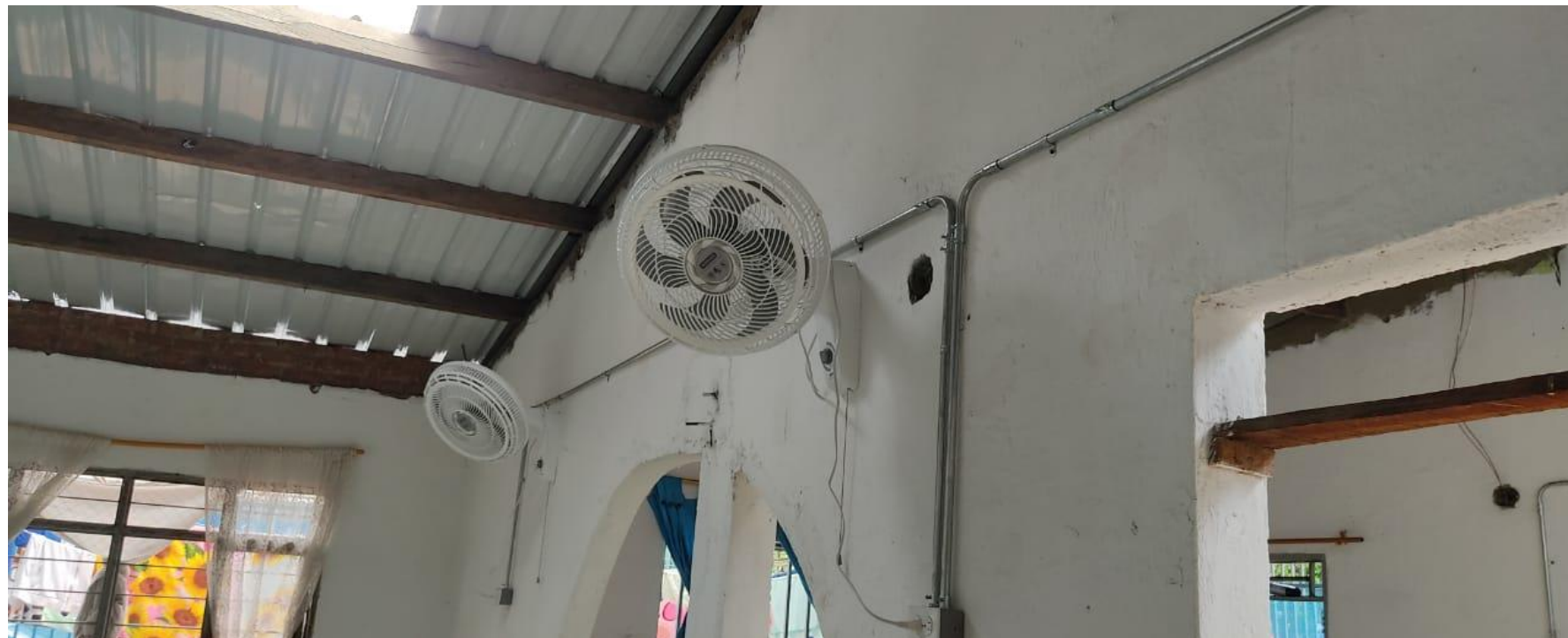
IMÁGENES — ESTADO FINAL — SUMINISTRO E INSTALACIÓN DE VENTILADORES DE MURO
