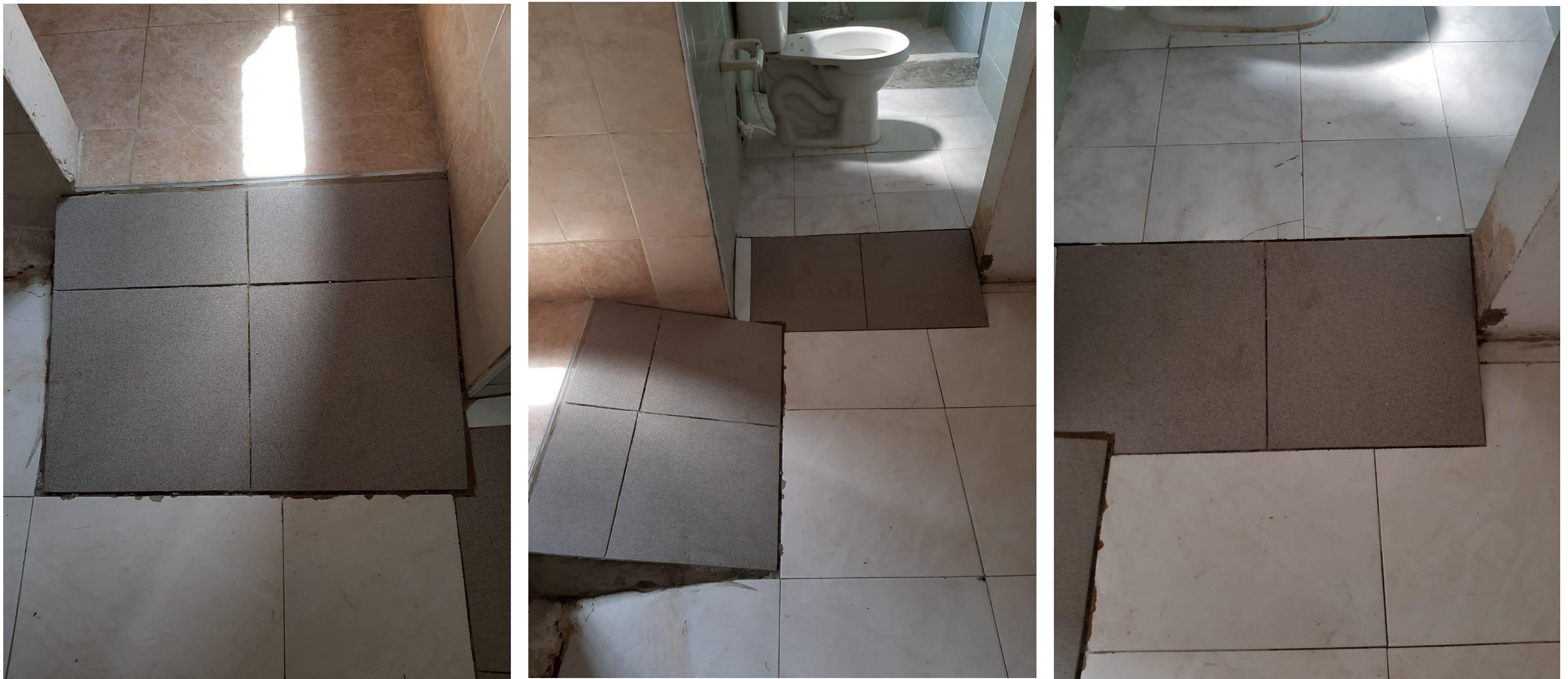
IMÁGENES — ESTADO FINAL — CONSTRUCCIÓN DE RAMPAS DE ACCESO A BAÑOS
