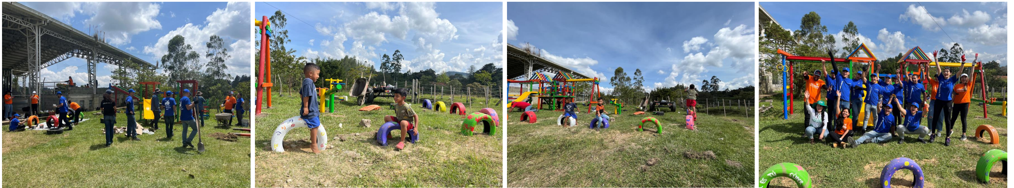
SUMINISTRO, INSTALACIÓN Y PINTURA DE PARQUE INFANTIL — BARRIO LA CONCHITA
